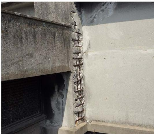
写真 柱露筋（屋上）
